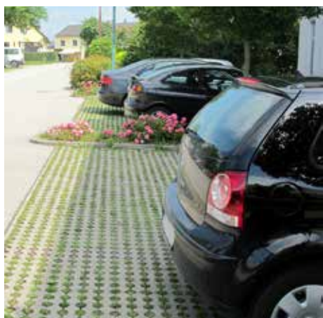
Mit Rasensteine werden Parkflächen nicht versiegelt.
