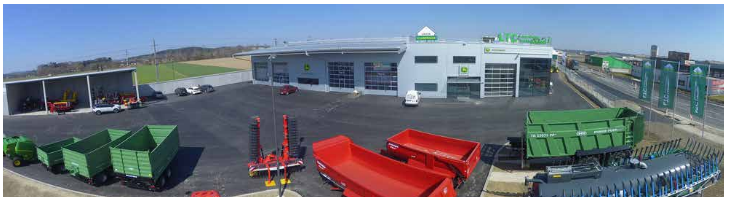
Nach nur zehn Monaten Bauzeit eröffnet das Lagerhaus TechnikCenter den neuen Standort in Redlham!
