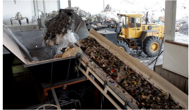
(Splittinganlage Redlham 2; Foto AVE)
